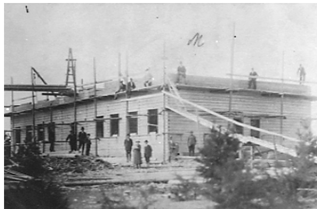
Kuva 2: Joentaan koulun rakennustyömaa 1924
